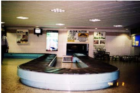
FOTO 6.10. BANDA TRANSPORTADORA PARA ENTREGA DE EQUIPAJES
