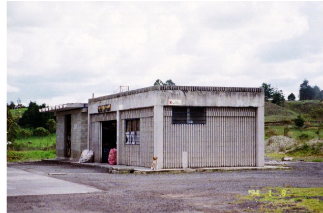
FOTO 8-3.1 ESTACIÓN DE SEPARACIÓN Y CLASIFICACIÓN DE RESIDUOS AEROPORTUARIOS
