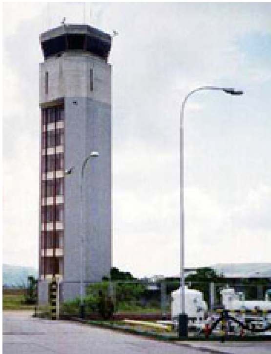
FOTO 6.2. TORRE DE CONTROL
