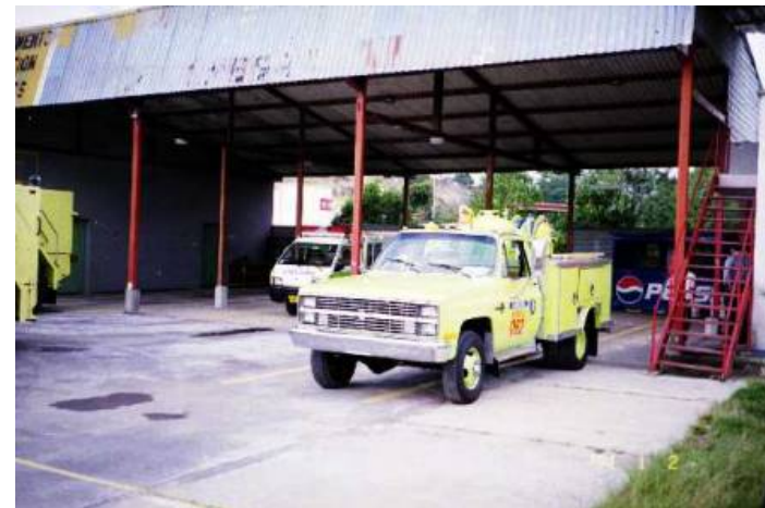
FOTO 6.1. ESTRUCTURA CUBIERTA DEL GSEI
