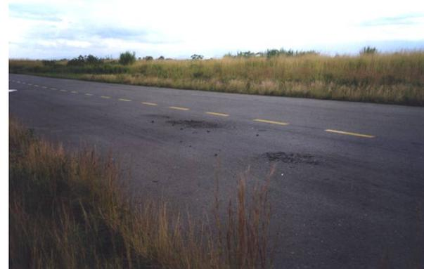
Otro procedimiento de evaluación recomendable consiste en transitar un equipo rodante de unas 10 a 15 toneladas de peso por tren de ruedas (un camión lastrado o un compactador neumático), con el fin de detectar y marcar zonas con deficiencia estructural (baches o rebotes). El equipo pesado busca simular el paso del tren de aterrizaje de una aeronave.
